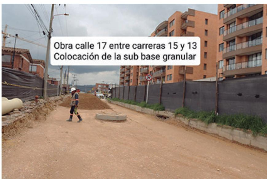
Obra calle 17 entre carreras 15 y 13 Colocación de la sub base granular
