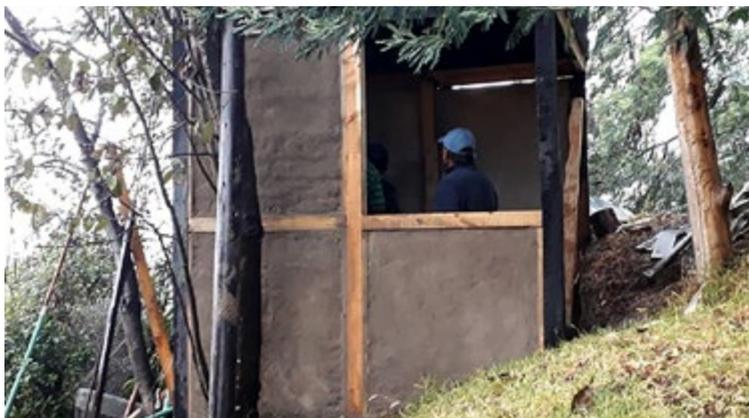
**Figura 3.** Construcción muro en Bahareque.
