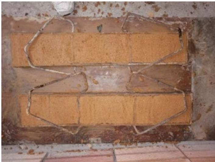
**Figura 9.** Moldeado de ladrillos, mezcla húmeda
