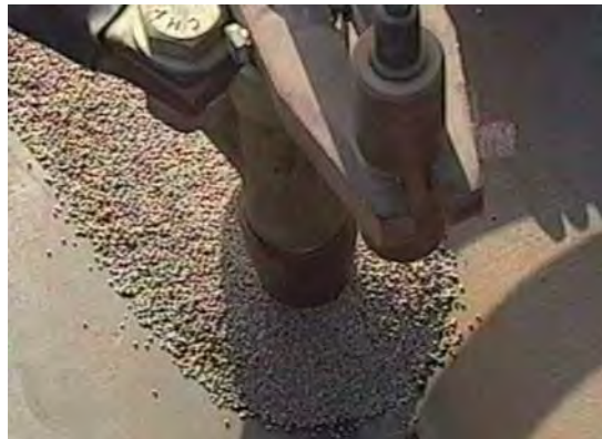
Ilustración 28, procedimiento de soldar con arco sumergido ( www.demaquinasyherramientas.com )
