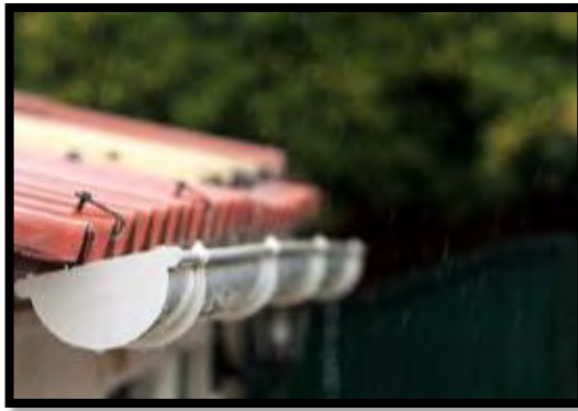
Figura 75. Canales de Pvc
