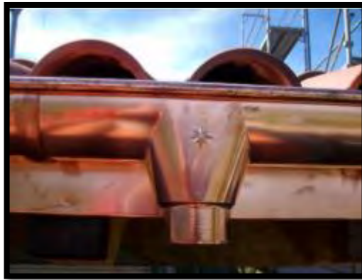
Figura 73. Canales de cobre
