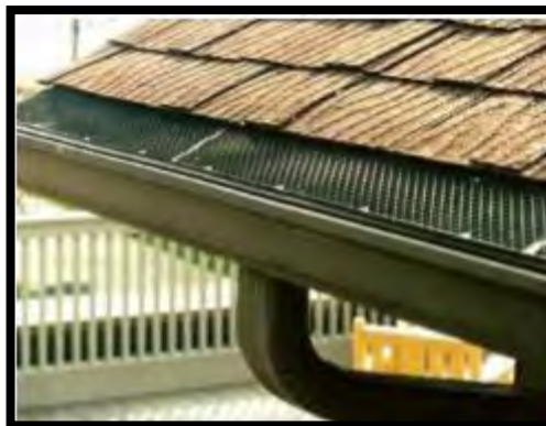
Figura 76. Canales de malla
