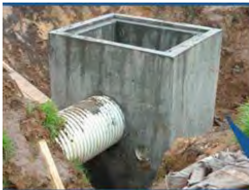
Figura 55. Cajas de inspección
