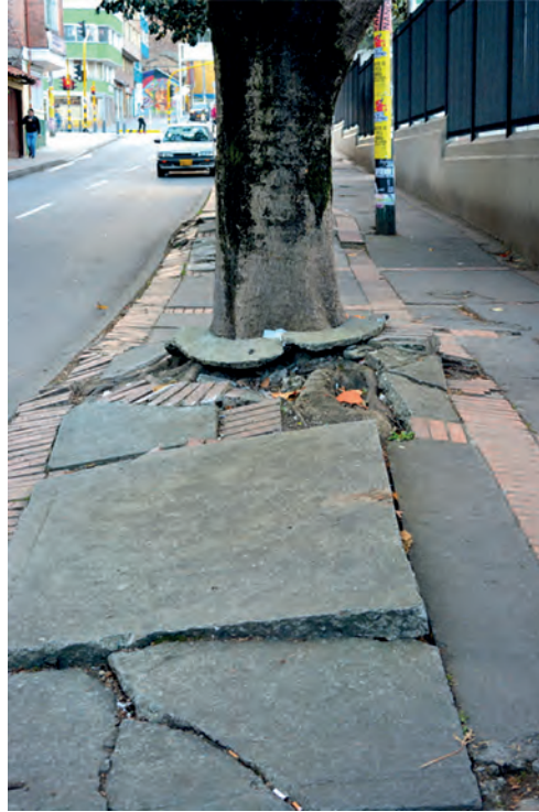
Figura 7. Daños por F. tequendamae . Calle 22, carrera tercera. Bogotá. Fuente: elaboración propia.
