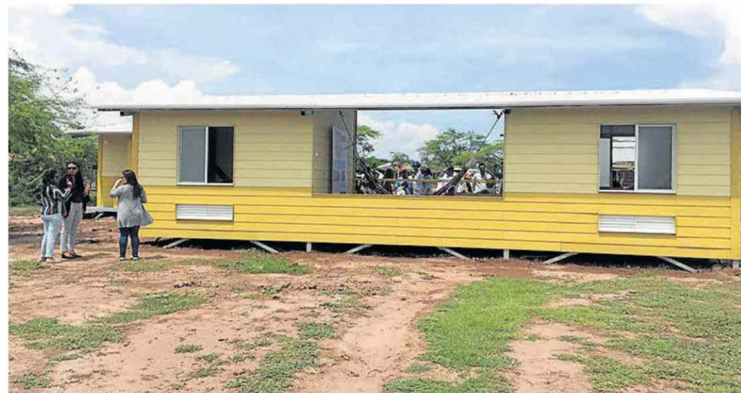
Las viviendas surgieron como una propuesta del Comité de Estructuras Metálicas de la Cámara Fedemetal de la Andi.
