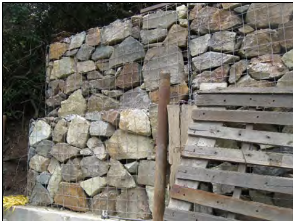
Figura 1. Utilización de agregados gruesos como gaviones.
