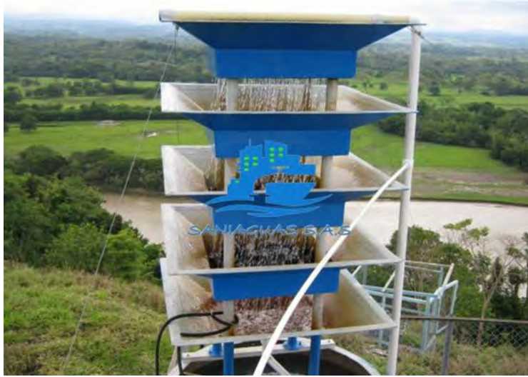
Figura 3. Torre de aireación convencional usada en plantas de tratamiento de agua potable.
