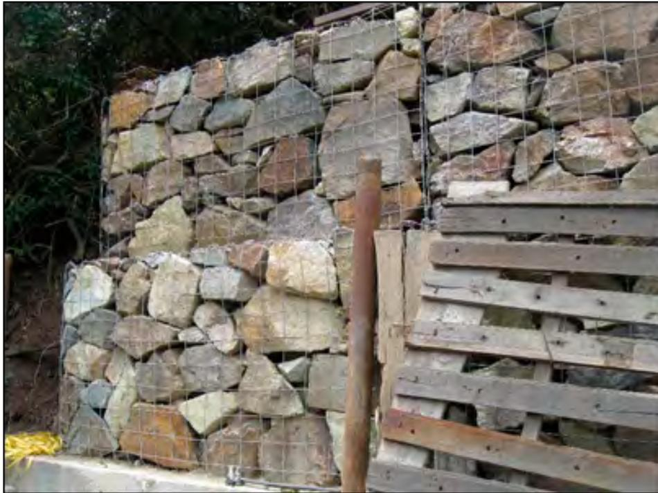
*Figura 1.* Utilización de agregados gruesos como gaviones.
